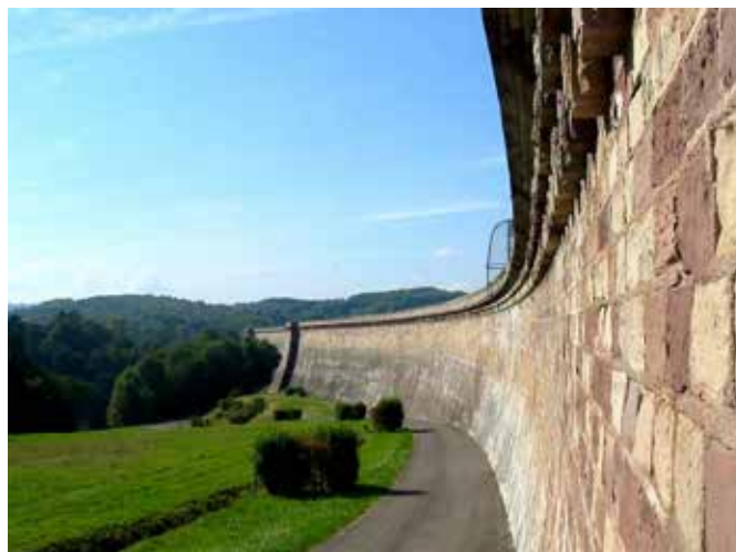
Le barrage du Bassin- ©Alain Jacquot-Boileau
